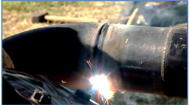
Figura 10. Proceso de Soldadura por arco a cañerías de acero.
