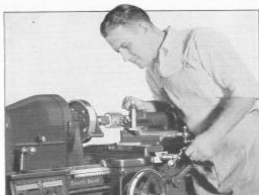
Fig. 204. Fileteado en el torno
