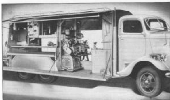
Fig. 338. Taller mecánico portátil montado en un camión grande
